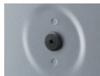
デッキサイド部
